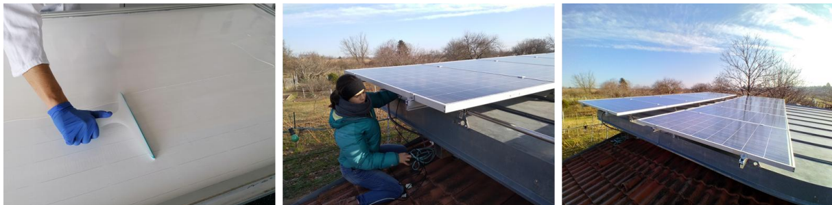
图6：照片展示了老化组件背面破裂的涂覆过程（左侧），现场材料和粘合度测试（中间），以及自2021年以来修复/涂覆的PV模块成功运行的测试地点（右侧）。在修复涂层中使用了流动硅酮和双组分聚氨酯涂层[10,11,33]。
