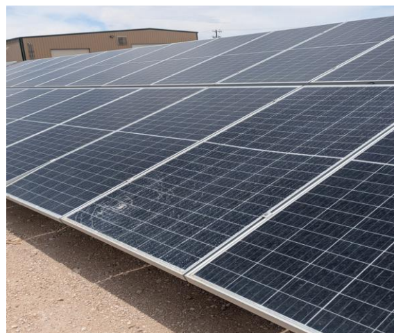
图14：概述SOLARCYCLE的二次利用光伏安装情况，该安装由退役的光伏模块组成，并对它们的剩余功率输出进行了评估。底部右图展示了安装中的PV1阵列，其中展示了带有破碎玻璃但仍能发电的回收光伏模块的例子。
