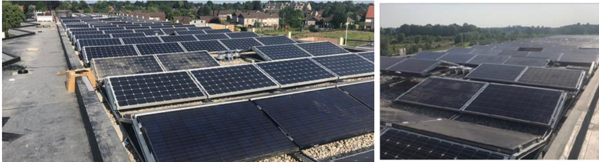
图22：屋顶上安装的第二生命期光伏系统的视图，展示了再利用光伏模块的多样性，包括光伏技术和功率输出。
