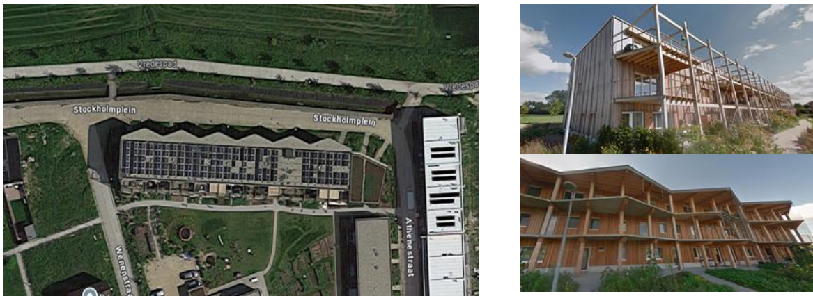
图21：左侧：瓦兹兰德演示建筑物的卫星视图，及其屋顶上的二次利用光伏系统。右侧：搭载二次利用光伏和储能系统的建筑外部视图。
