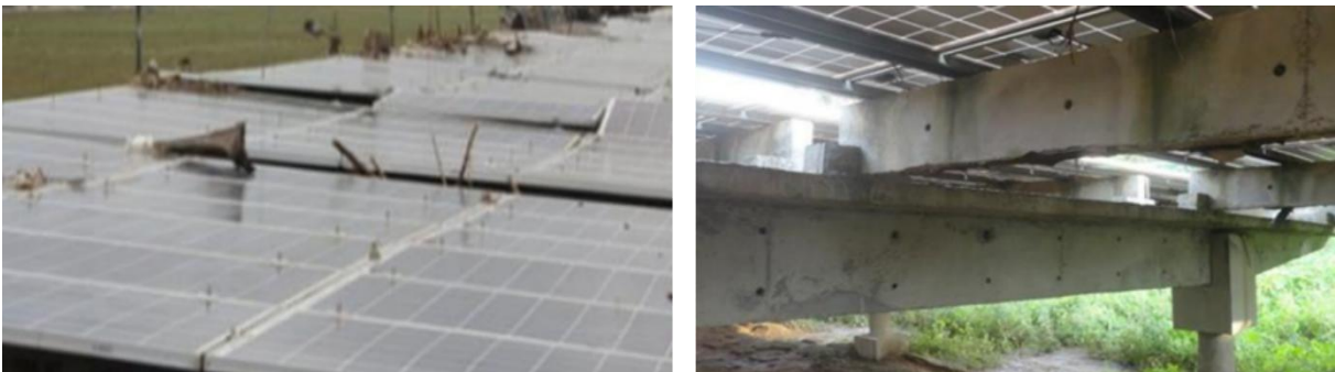
图30：带有混凝土结构的渠道顶部光伏系统对洪水表现出弹性，因为低倾斜设计对快速流动的水阻力较小。
