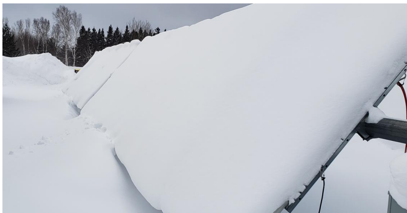
图15：密歇根区域试验中心（RTC）的跟踪系统上承受着重大的雪载，加上较深的积雪和一些雪漂移，导致该系统暂时无法运行。照片来源：保罗·W·戴奇。
